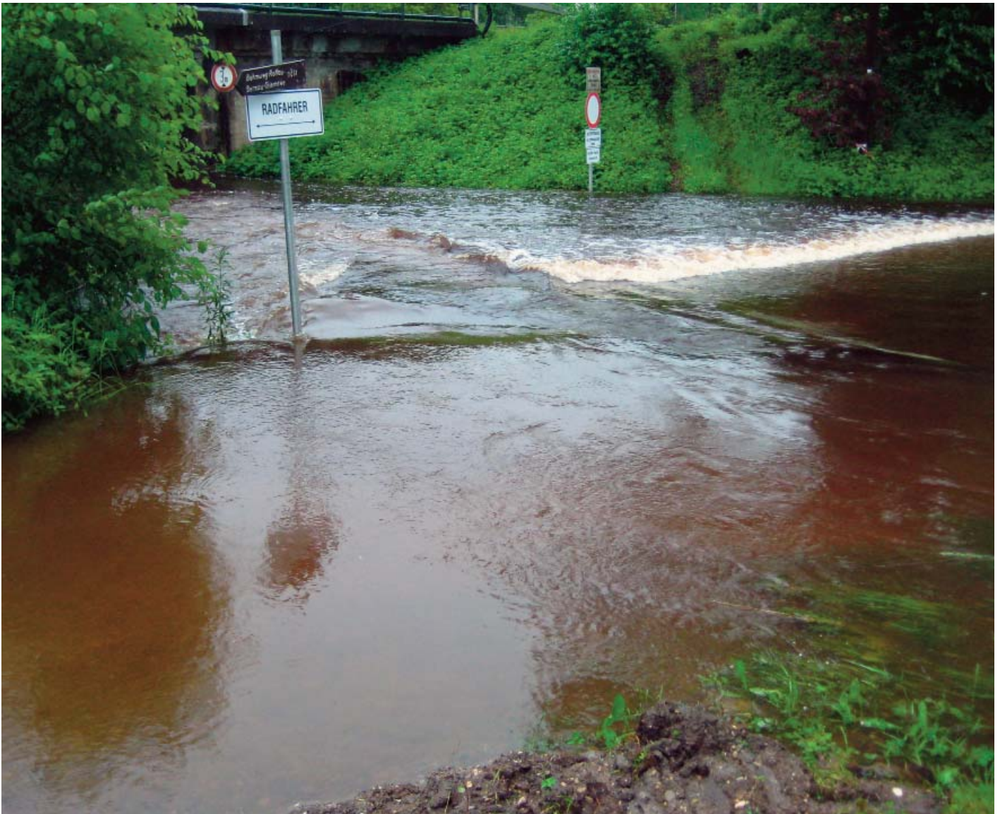
Abb. 3: Hochwasser 2013 am Torfbahnhof: Große Wassermengen können vom Kanal nicht mehr aufgenommen werden und strömen direkt durch die Bahnunterführung.
