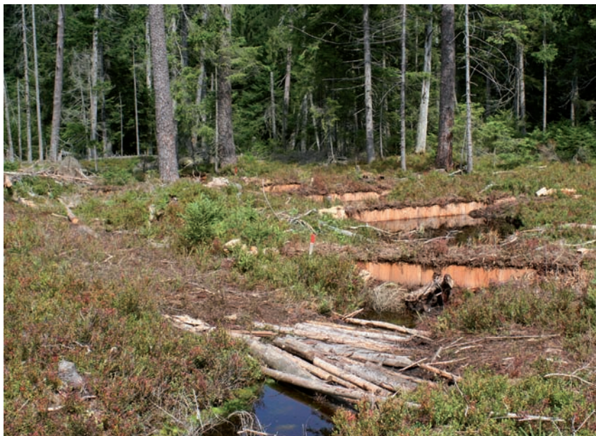
Abb. 11: Im Jahr 2013 neue errichtete Sperren im Harzmoos mit engem Abstand. Beim Bau entstanden massive Schäden auf der Mooroberfläche und in den Torfen (29.08.2013).
