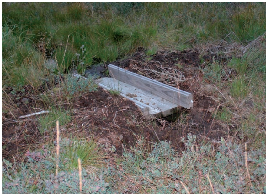
Abb. 18: Die Sperre am Südrand des Elzhofmoores wurde bei einer Renaturierungsmaßnahme für das Moor errichtet. Schon damals lag die Wasserrinne weitgehend trocken auf dem nackten Torf (02.09.2014).
