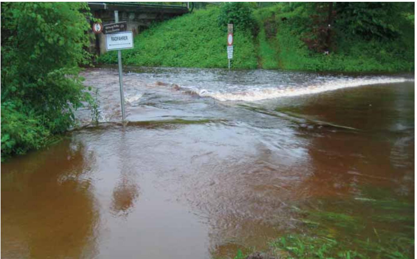
Abb. 1 b: Hochwasser im „Unterlauf“ der Kendlmühlfilzen bei der Bahnunterführung am Torfbahnhof.
