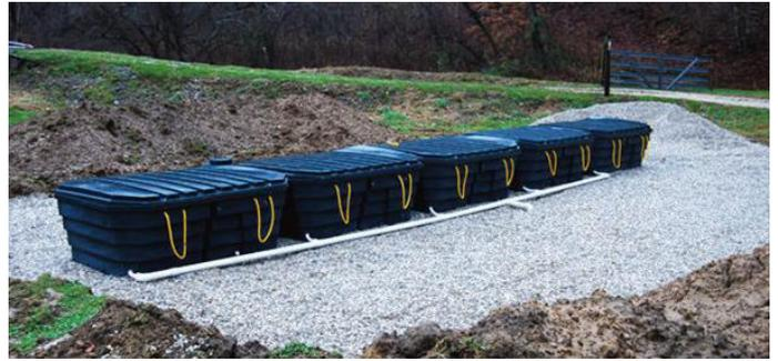
Abb. 6b: Modulanordnung der mobilen Abwasserbehandlung für größere Kapazitäten.
