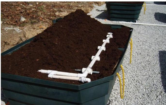
Abb. 6a: Abwasserbehandlung mittels Torfbett: Einzelmodul.
