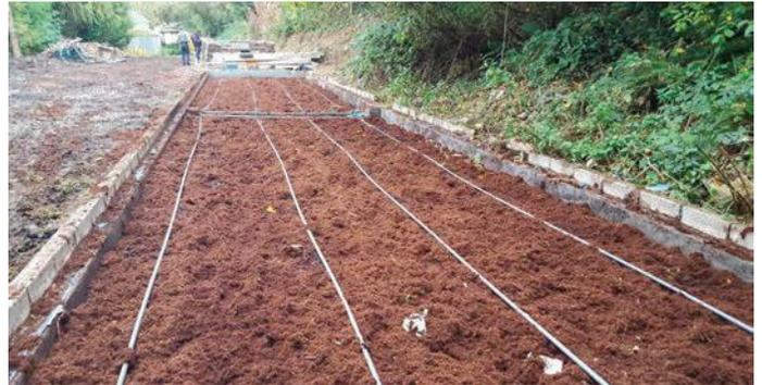
Abb. 6c: Lokale Abwasserbehandlung mittels stationärem Torfbett, z. B. für Entwicklungsländer ohne Infrastruktur.
